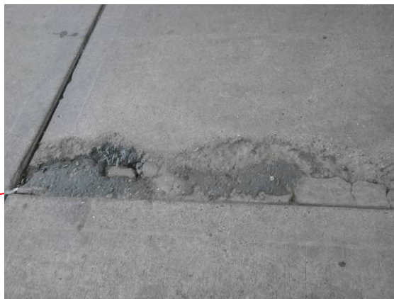
Área de distribución de combustible con pisos en concreto en mal con pérdida de concreto en la superficie.
