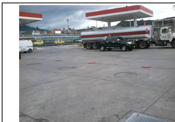
Foto No. 5. Vista panorámica de la estación de servicio desde la entrada de la Calle 27 Sur.
