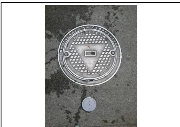
Área de distribución de combustible con pisos en concreto en mal con pérdida de concreto en la superficie.
