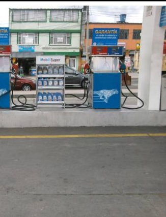
Área de distribución de combustible con pisos en concreto en mal con pérdida de concreto en la superficie.
